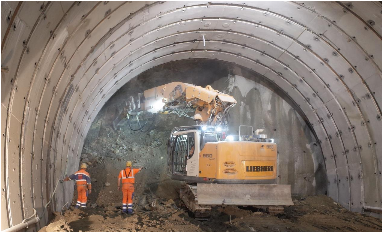
Tunnelvortrieb – Ausbruch Kalotte mit Abbauhammer
