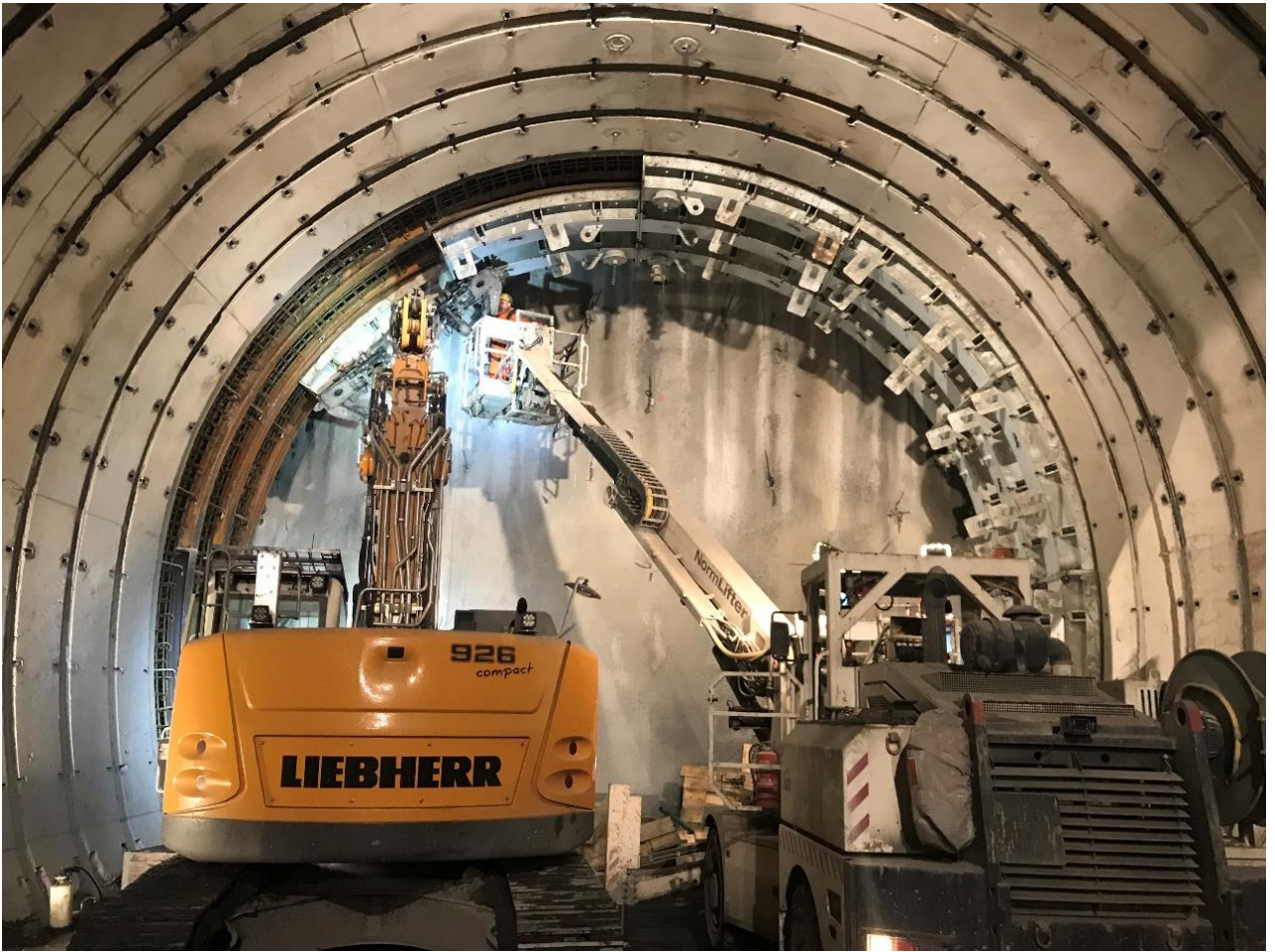
Montage der Tunnelschalung für die Ausbruchsicherung
