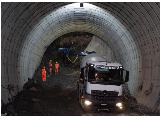
Ausbruchsicherung mit Stahlfaserspritzbeton an der Ortsbrust
