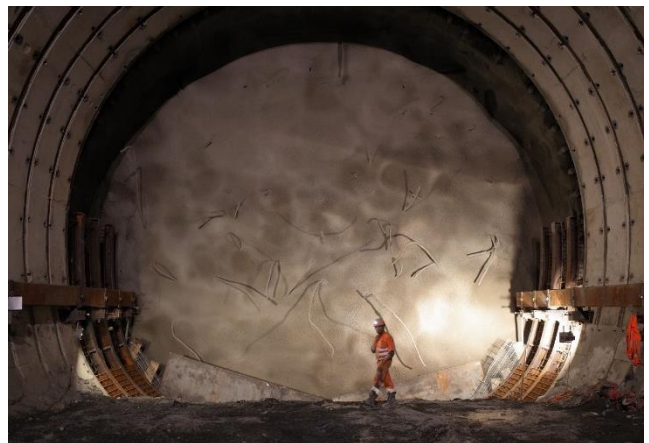
Gesicherte Ortsbrust, bewehrtes Sohlgewölbe und Stahlbogen
