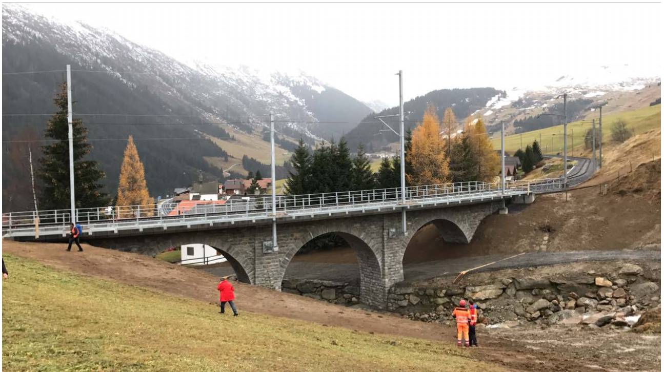
1. fertiggestelltes Viadukt (Foto: NL Brunnen)
