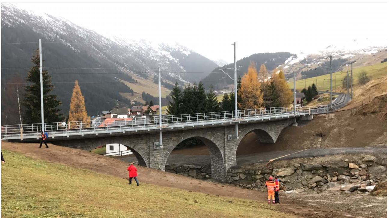
1. fertiggestelltes Viadukt (Foto: NL Brunnen)
